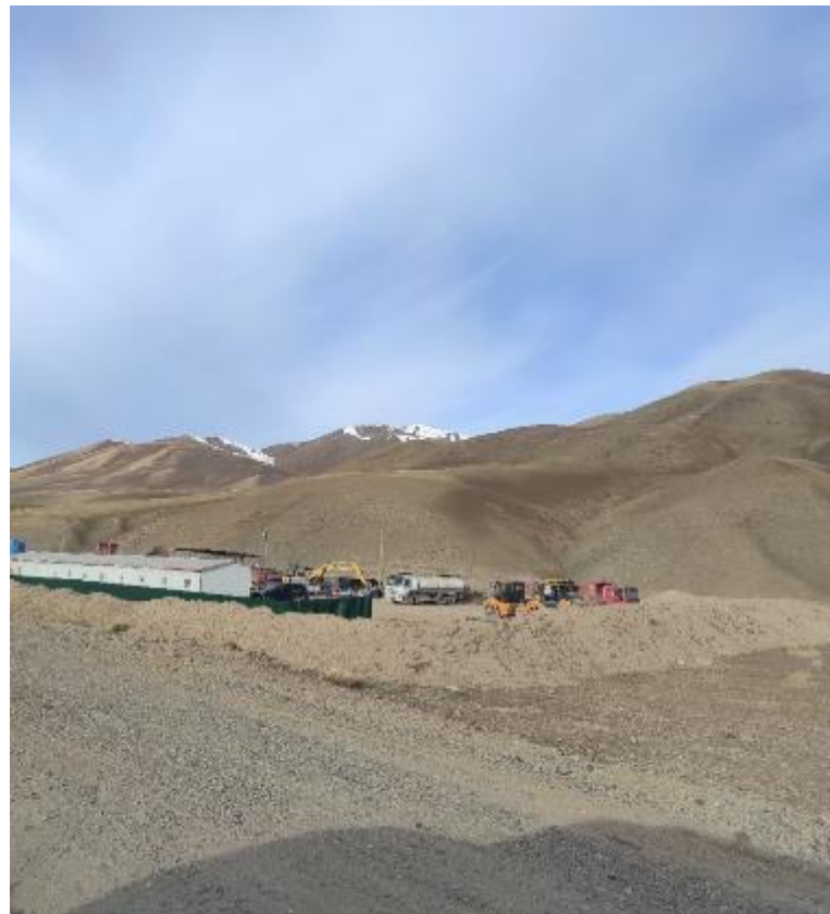
Рисунок 23: Территория второго строительного лагеря (км 106+300)
