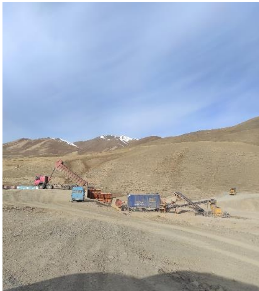
Рисунок 21: ДСУ на территории производственной площадки (км 106+300)
