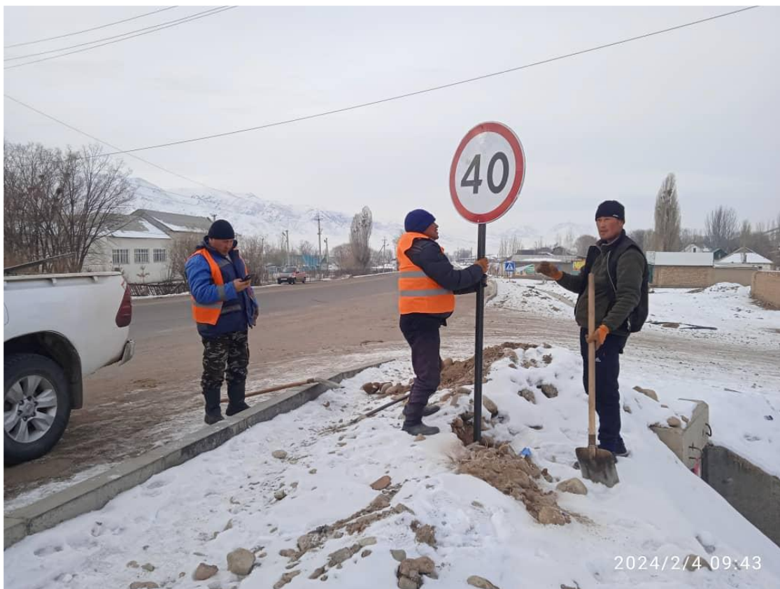
Рисунок 5: Установка временных указателей, км 127+650 правая сторона
