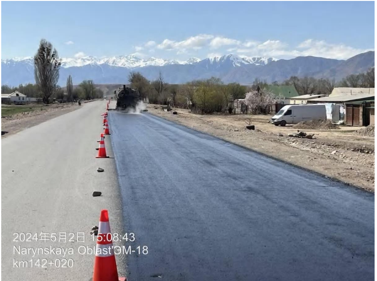
Рисунок 11: Нанесение защитного покрытия, км142+020-км143+020 правая сторона
