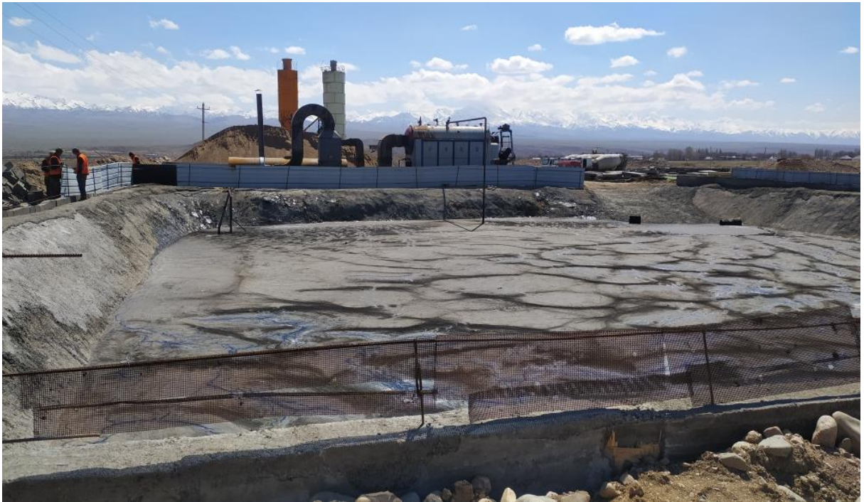
Рисунок 20: Битумная яма на территории производственной площадки (км 148+630)
