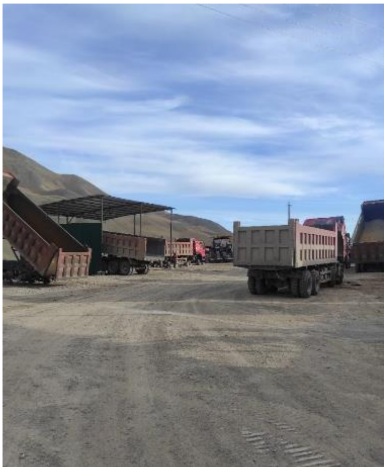
Территория второго строительного лагеря (км 106+300)
