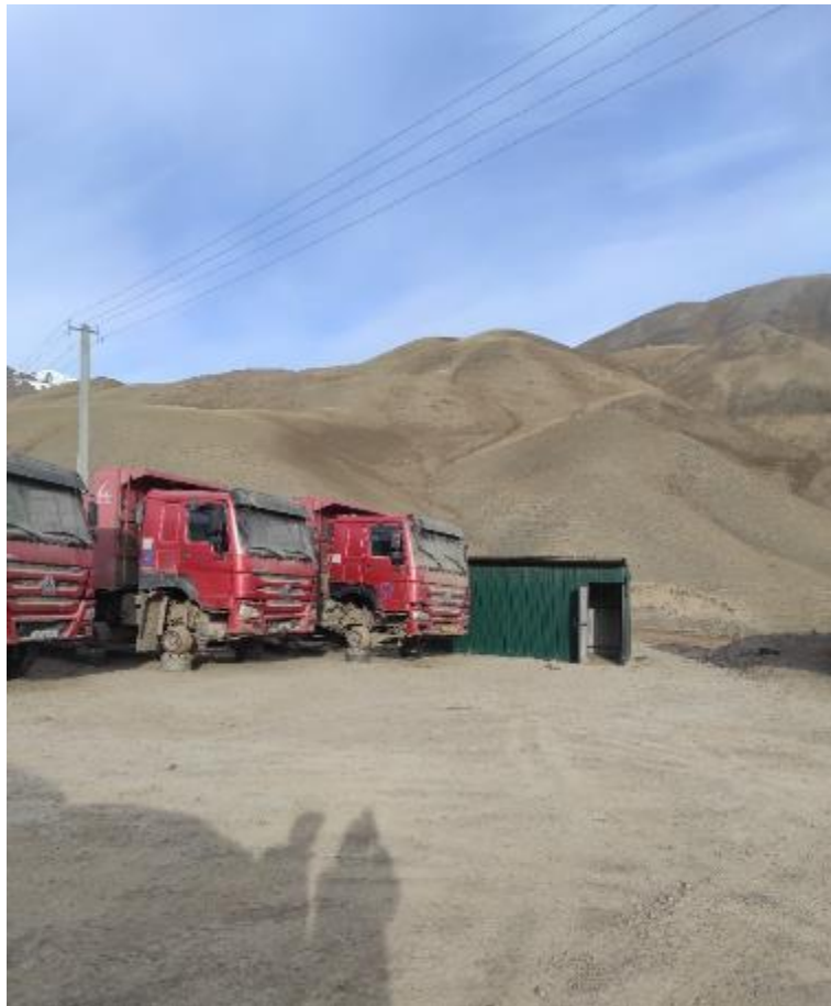
Территория второго строительного лагеря (км 106+300).
