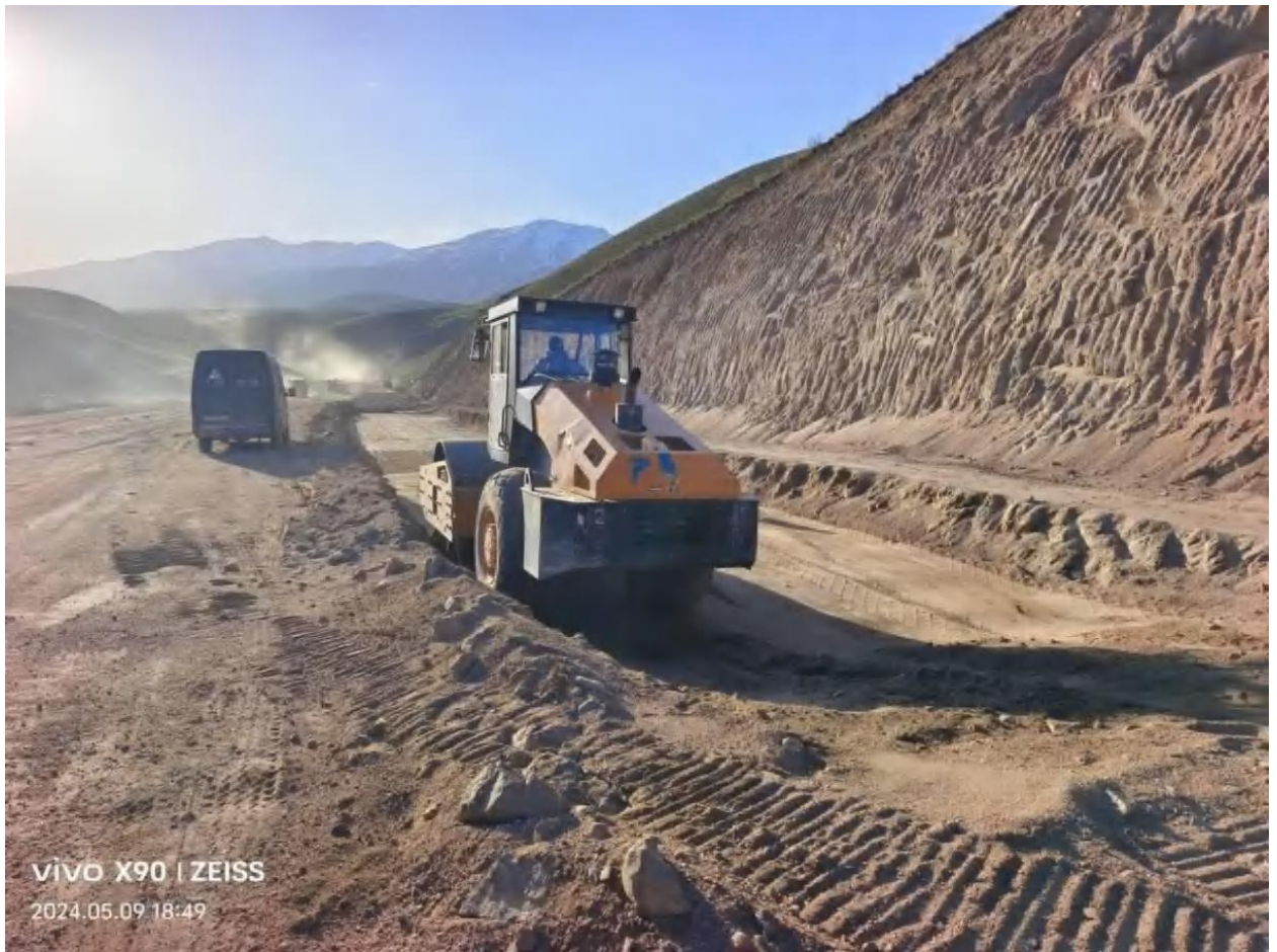
Рисунок 13: Формирование насыпи, км 113+600 – км 113+680 правая сторона
