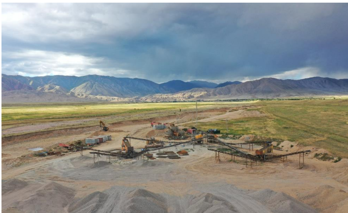
Рисунок 19: ДСУ на территории производственной площадки (км 148+630)
