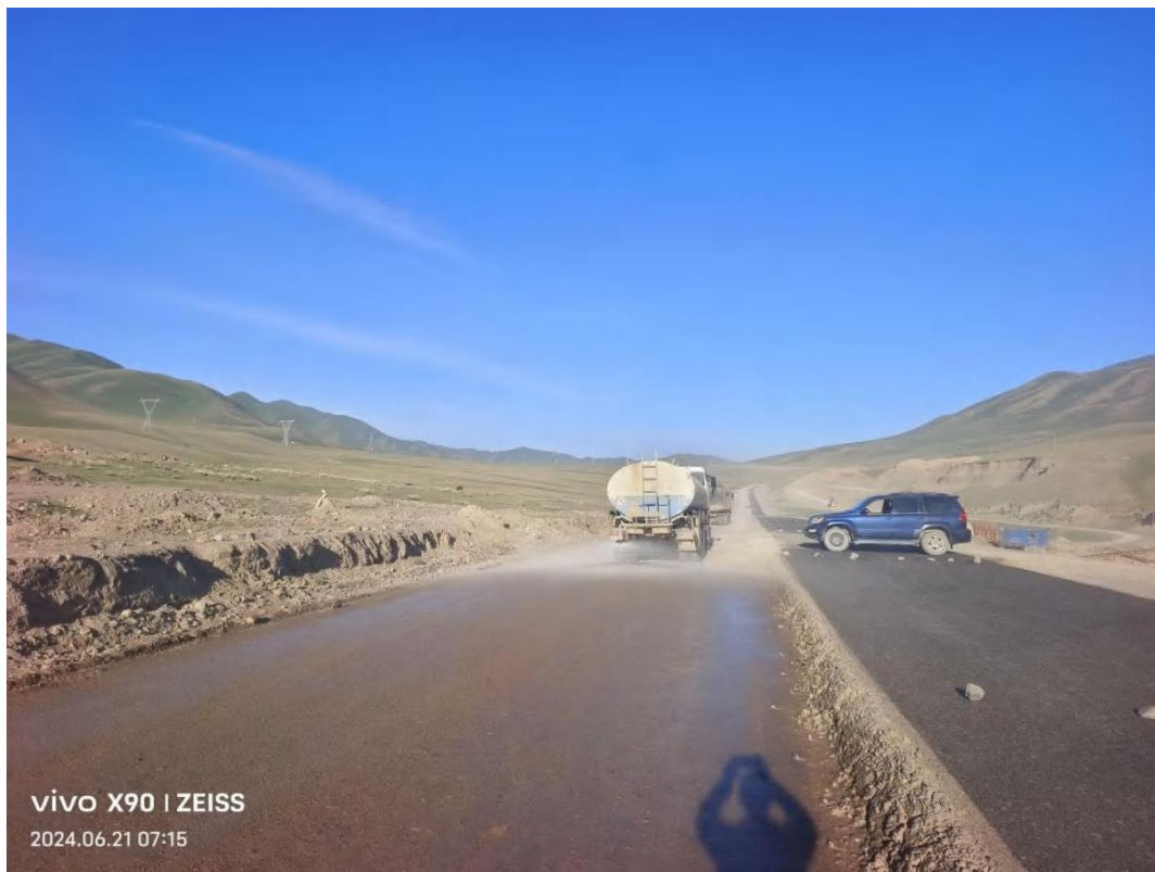
Рисунок 15: Пылеподавление на дороге
