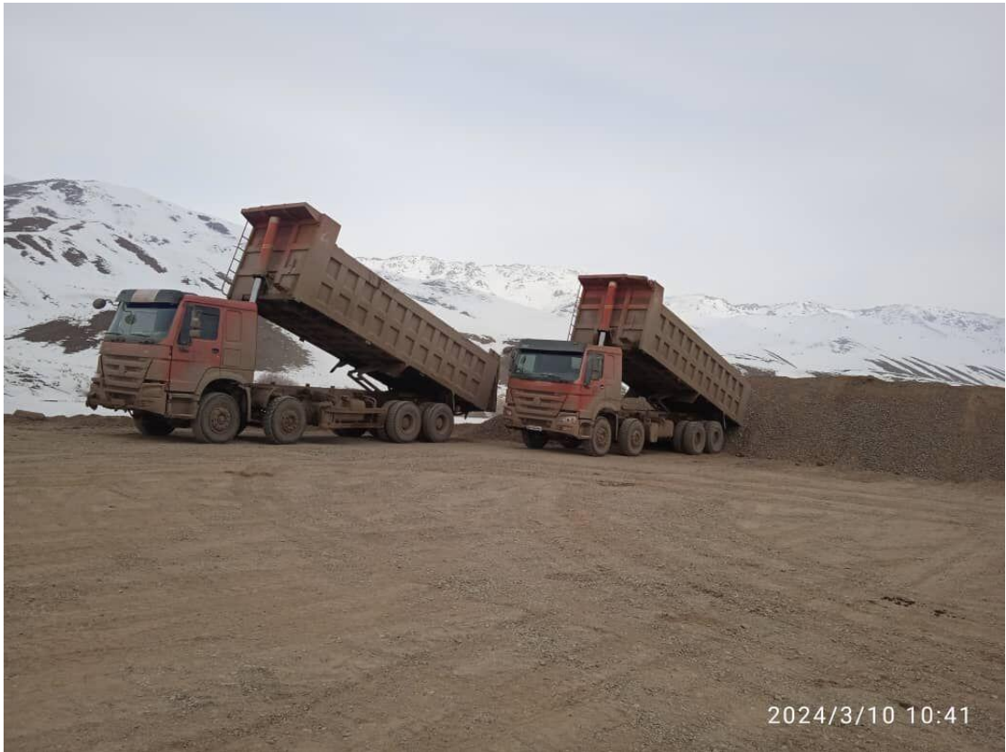
Рисунок 7: Транспортировка материала для основания на км122 с км106
