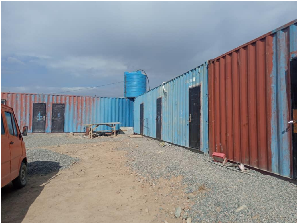
Территория второго строительного лагеря (км 106+300).
